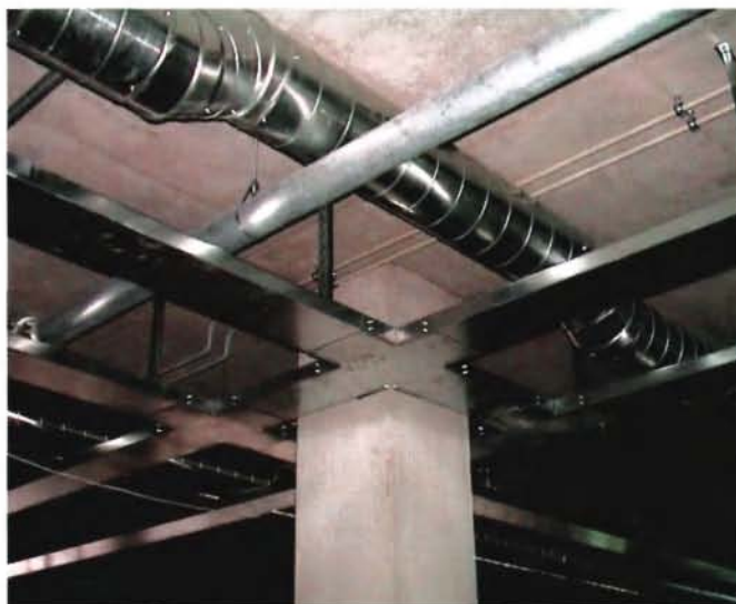
Abb. 2: Deckeninstallation im Freihandbereich, fotografiert im September 2003, Andreas Richter
