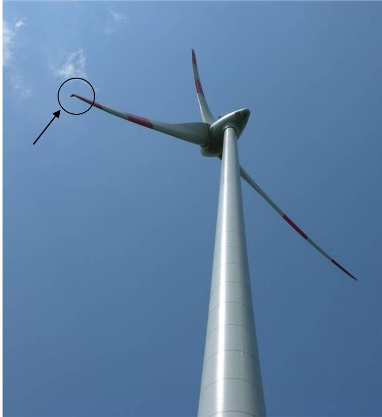
**Bild 5-2. Winglets an Rotorblättern einer WEA der Multimegawattklasse**
